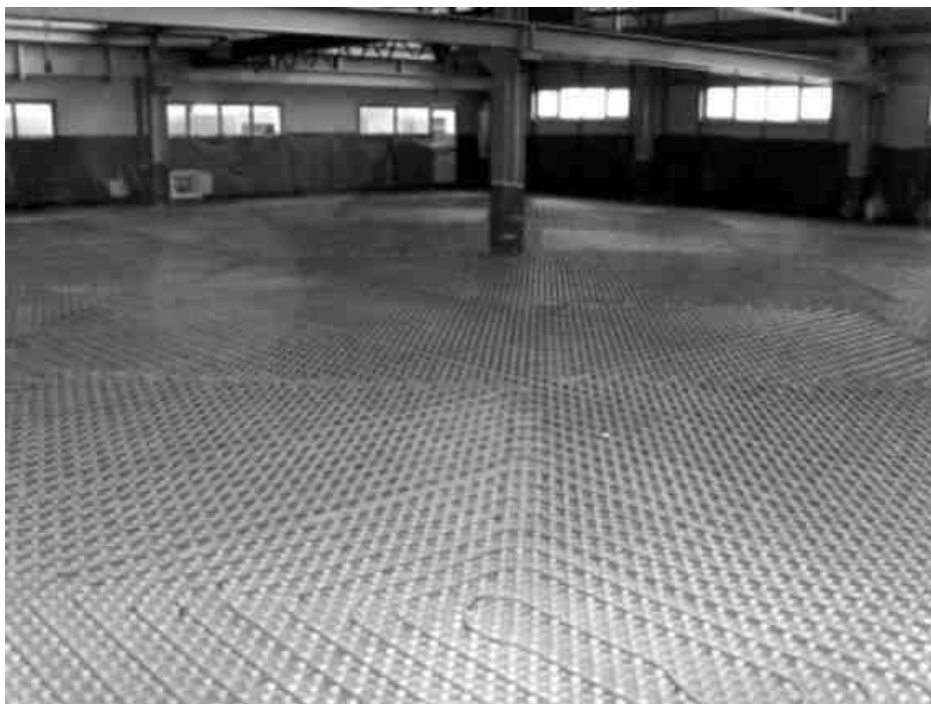
Slika 7: Razporeditev cevi za talno gretje in hlajenje
