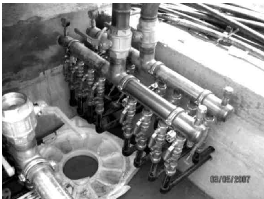
Slika 5: Razdelilnik geosond
