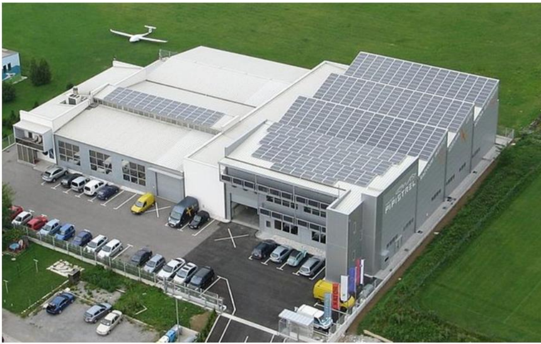
Slika 12: Pogled na končan objekt iz zraka
