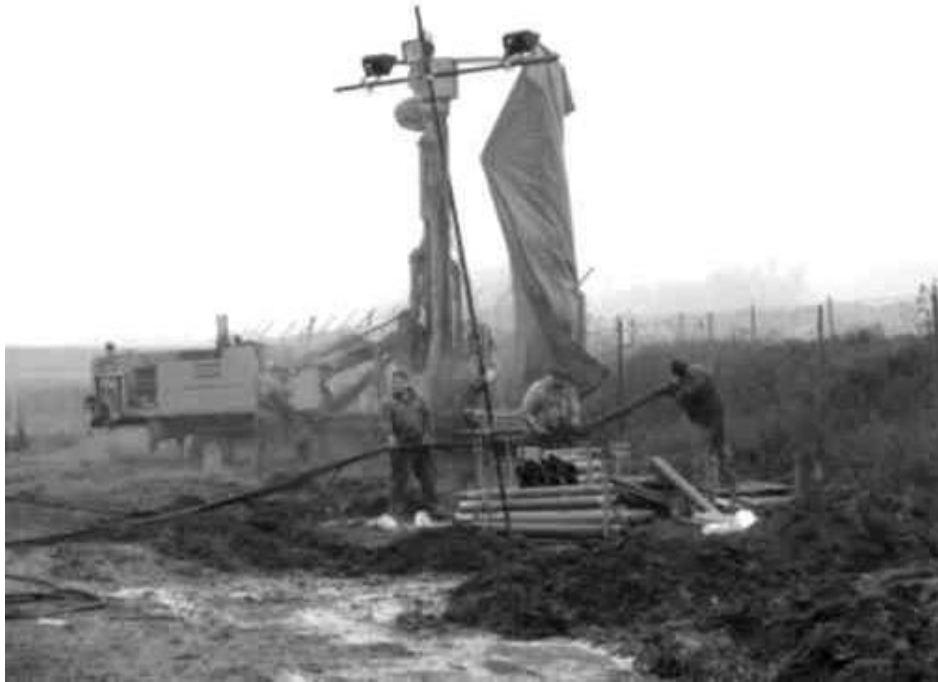
Slika 3: Vrtanje vertikalnih geotermalnih sond
